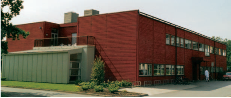
Morfologibygningen, som huser det vesentligste av Institutt for morfologi, Norges Teknisk-Naturvitenskapelige Universitet i Trondheim.
